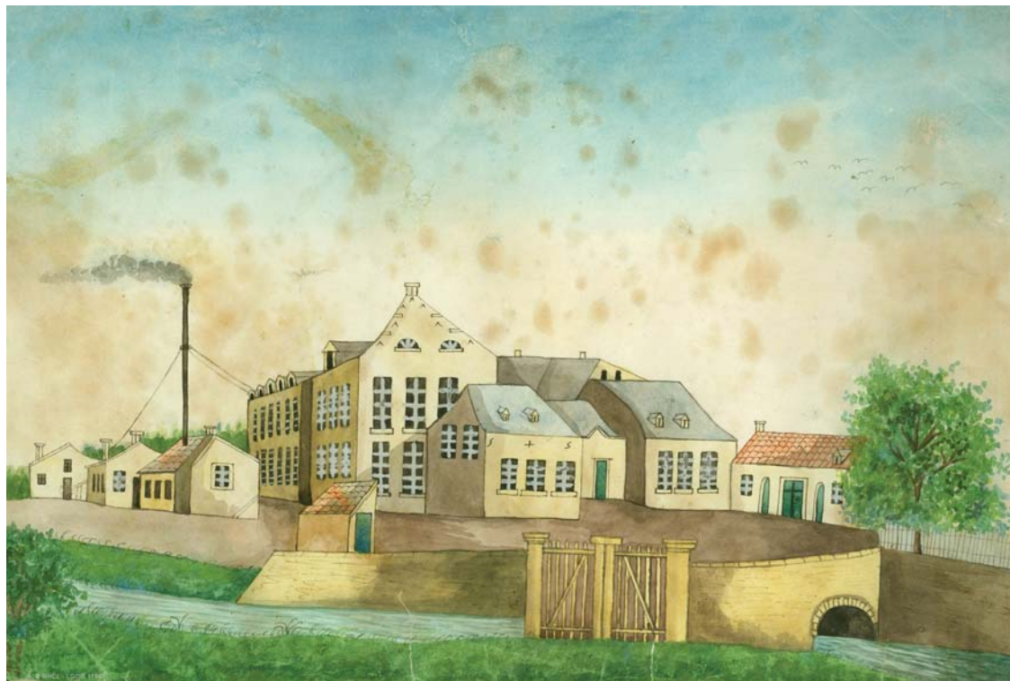
Tekening van Philip van Gulpen van de papierfabriek van Tielens en Schrammen, circa 1855. Op de voorgrond de Geul. Rechtsonder mondt de overdekte molenbeek uit in het riviertje. Het water van deze beek dreef oorspronkelijk de molenraderen en later de turbines van de fabriek aan.
